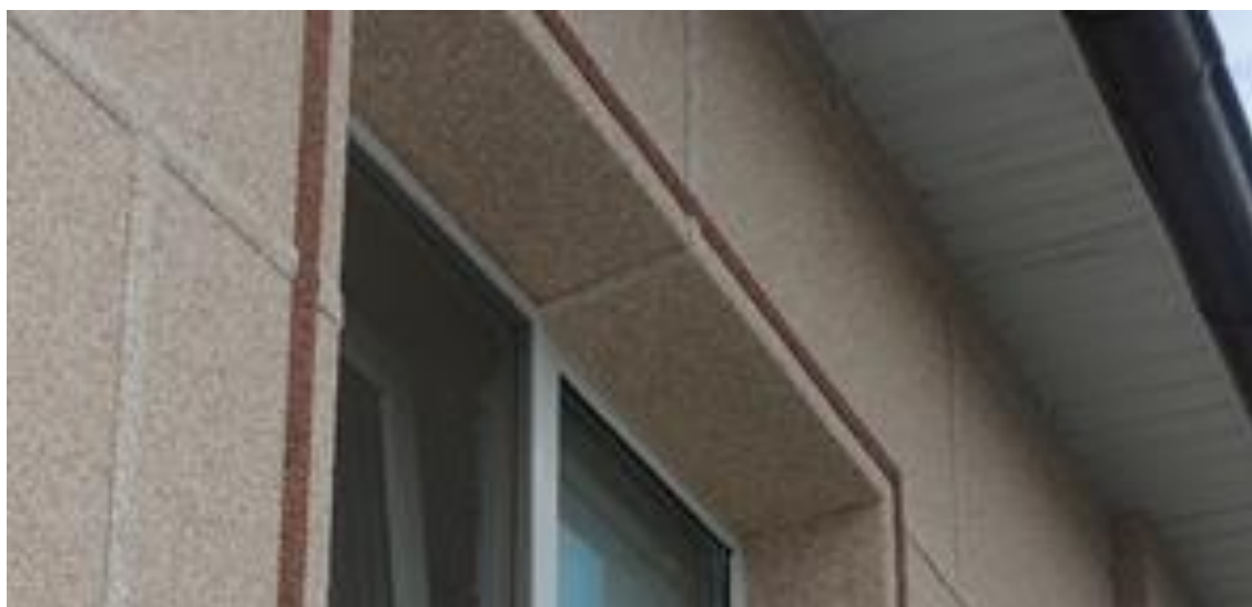
Рис. 4.7 Закрытие швов откоса т-образной декоративной планкой
