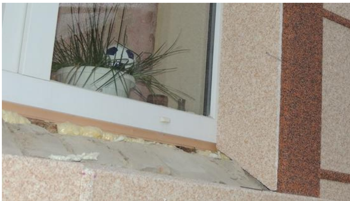
Рис. 4.8 Монтаж декоративного обрамления и накладки на откос
