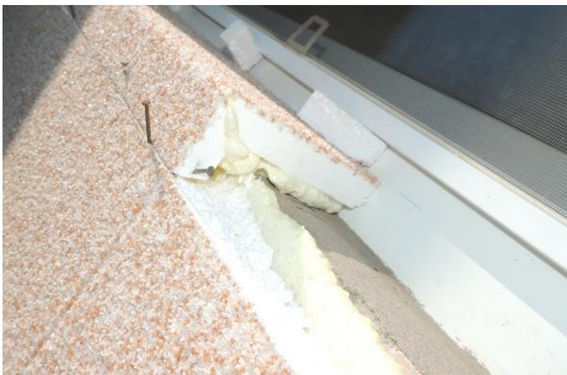
Рис. 4.6 Утепление откоса угловым элементом
